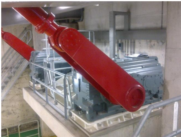
Foto: aandrijving Kraspolderbrug A (Alkmaar)
