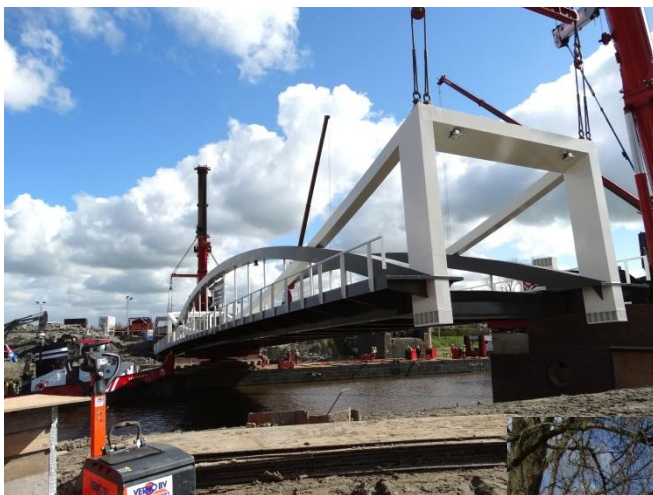
Foto: plaatsing Tafelbrug Dorkwerd
