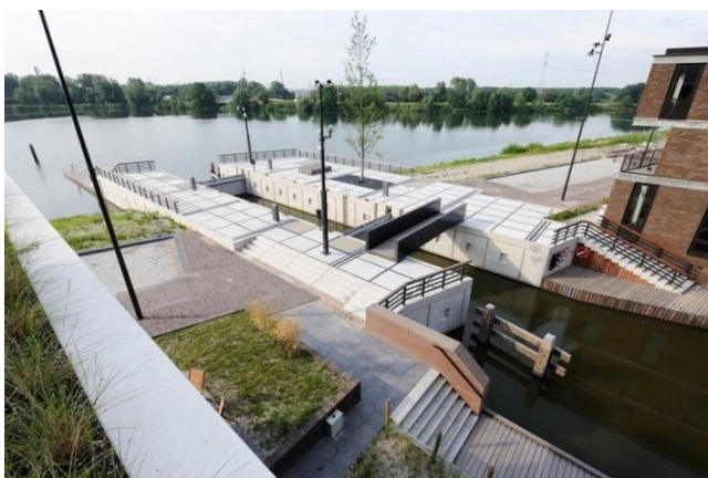
Foto: overzicht betonnen sluisdeuren Sluis 0124 (IJburg)
