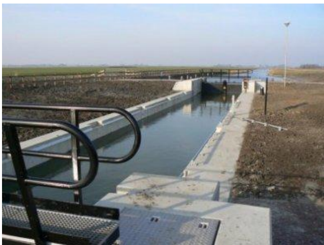
Foto: overzicht sluis “Oude Leije en Wier”
