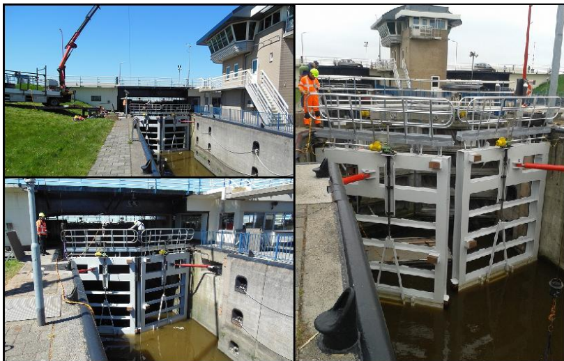
Foto's: Ebdeuren Tsjerk Hiddes Sluis Harlingen
