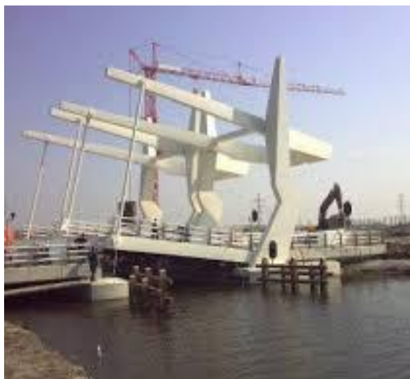
Foto: dubbele ophaalbrug over het Hoendiep te Hoogkerk (Westpoortbruggen).
